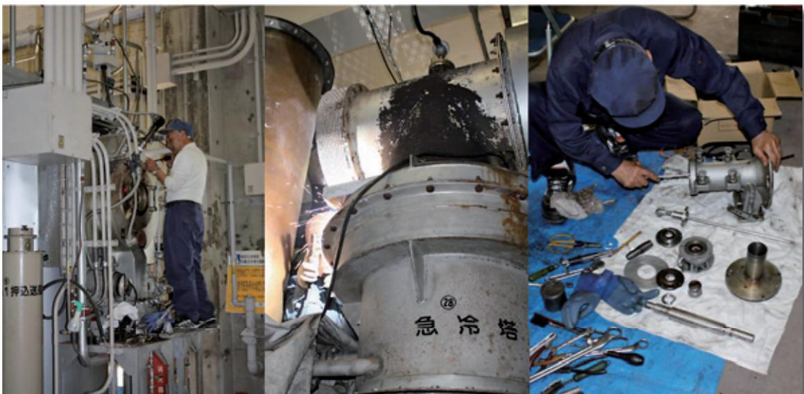
有機廃液焼却処理装置の補修工事 (炉のオーバーホールなど)
