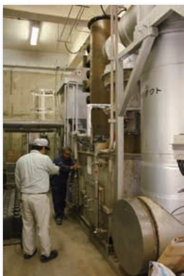
有機廃液処理装置の運転管理
