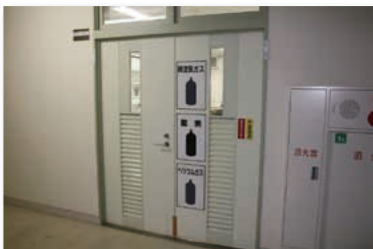
保管している高圧ガスの表示
