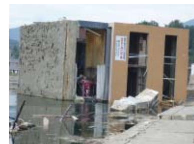
ビルが根こそぎ倒壊（女川町）
