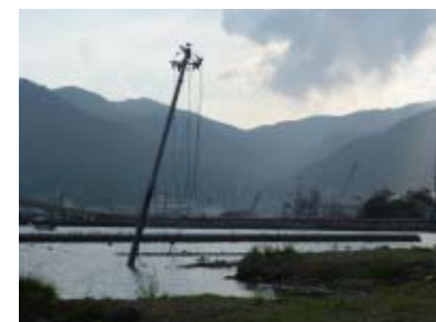
港地域全体が地盤沈下（大船渡市）
