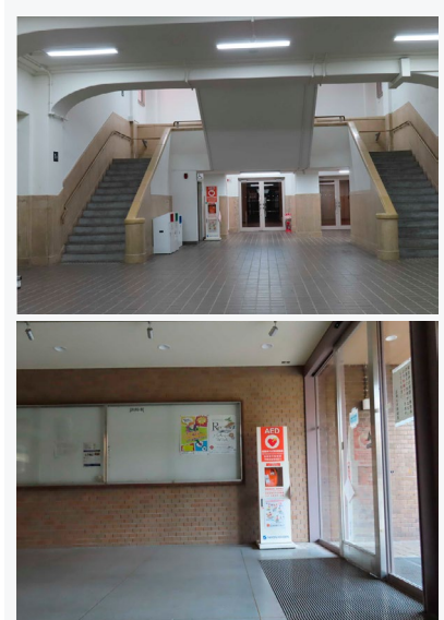
[Fig.5-2-4] AED設置場所 上:3号館エントランス/下:12号館エントランス
